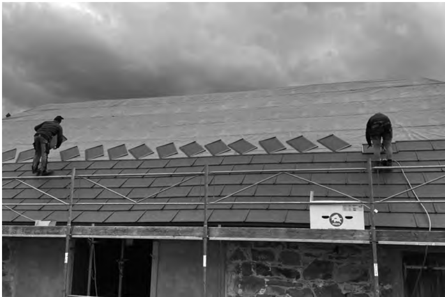
Dachneueindeckung der hinteren Stallung mit Prefaplatten auf Neugehren
